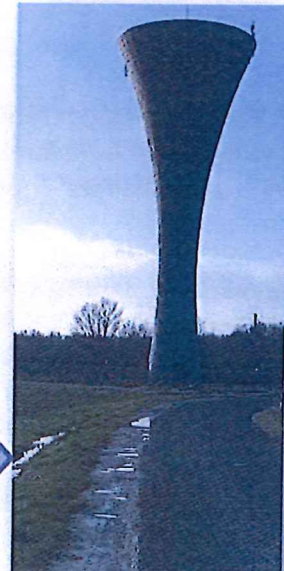
Château d'eau Val Bréon Châtres
