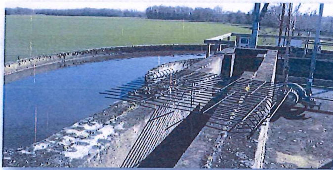
Station d'épuration La Houssaye-en-Brie
